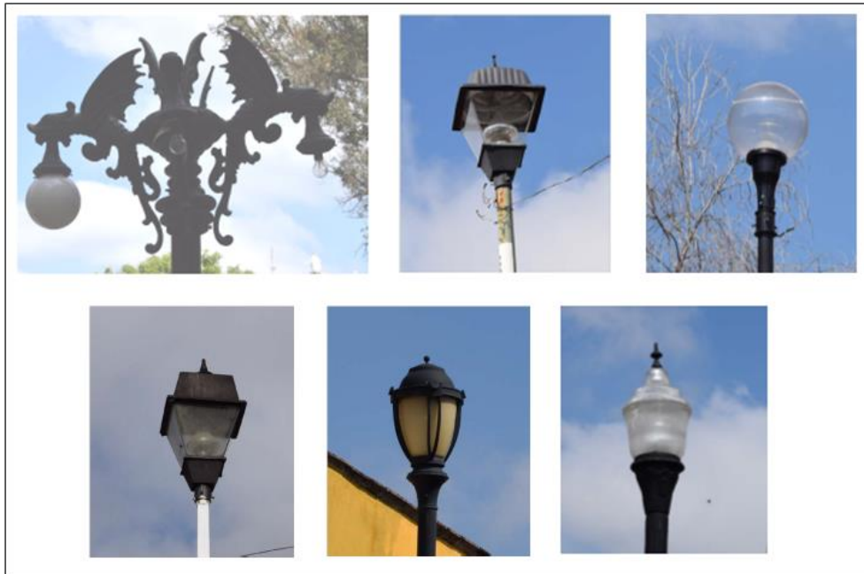
Imagen 21. Ejemplo de luminarias en las cuales se tendrán que instalar dispositivos de retrocompatibilidad.
