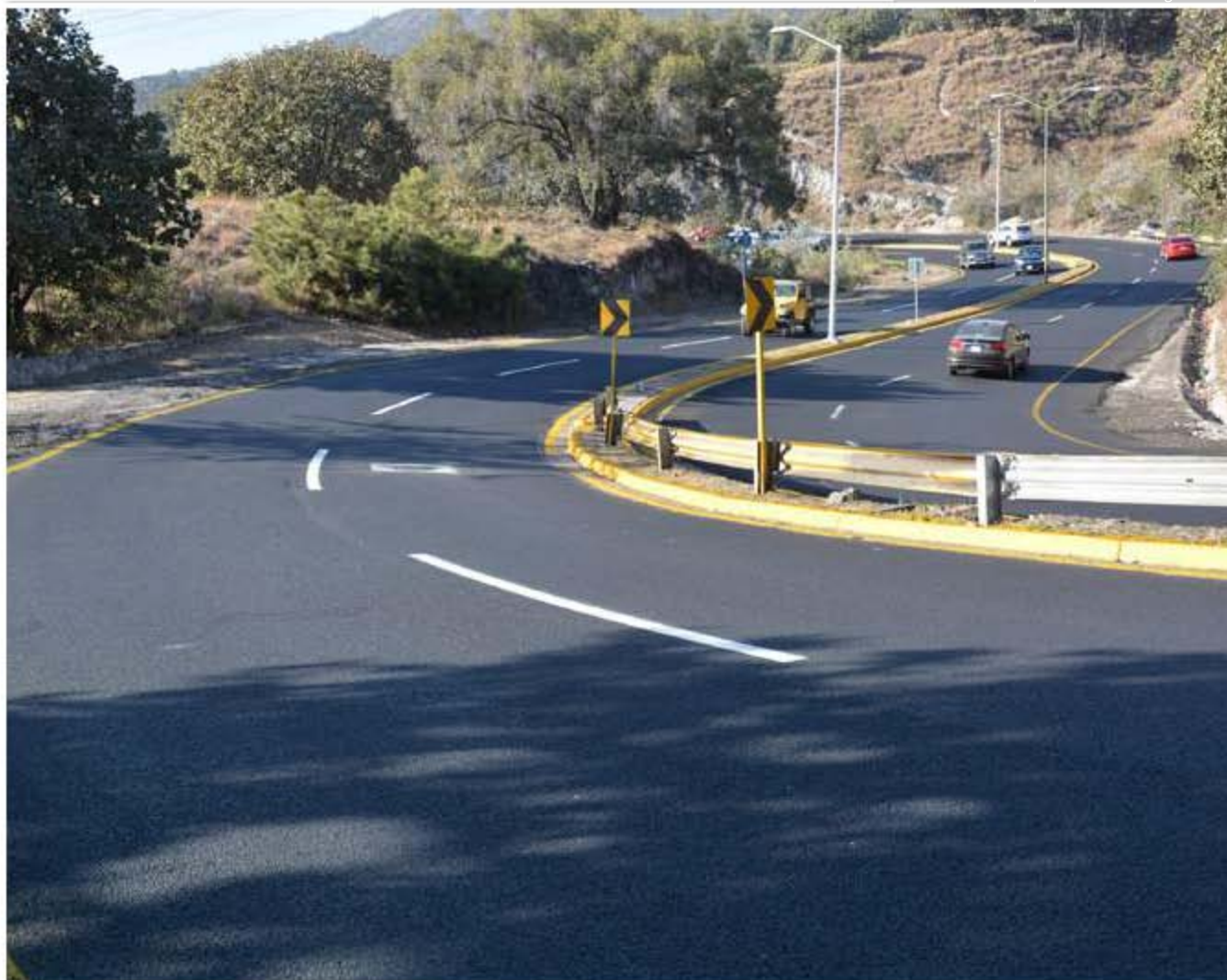
Pavimentación en fraccionamiento Bugambilias
