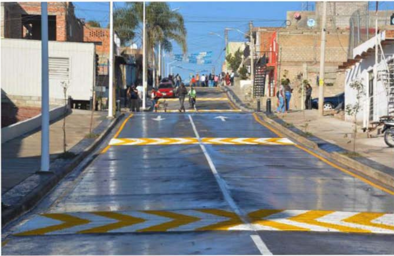
Pavimentación de calle Casiano Torres en Villas de Guadalupe
