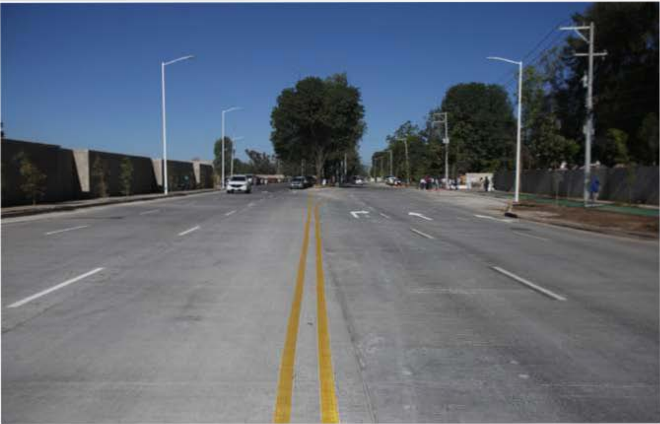
Pavimentación de avenida Ramón Corona segunda etapa
