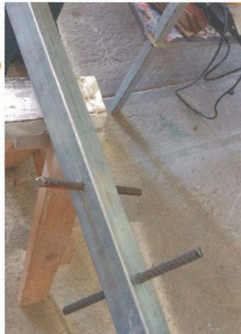
Figura II.7-2. Cimentación tipo para los postes de las señales bajas
