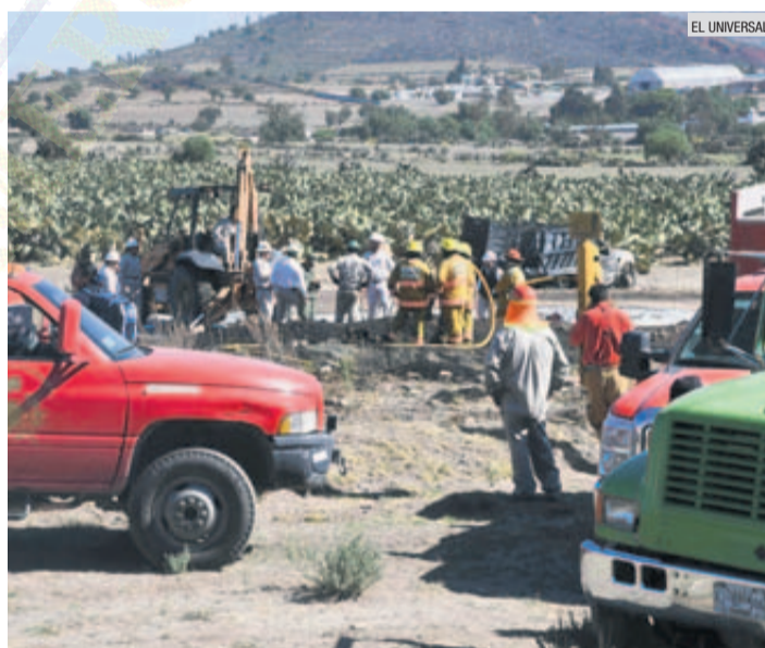
RIESGO. En el Estado de México también se reportó la explosión en un ducto.
