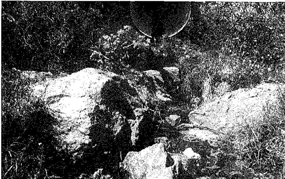
Foto. Cortesía | Gestión Integral de Agua y Drenaje
