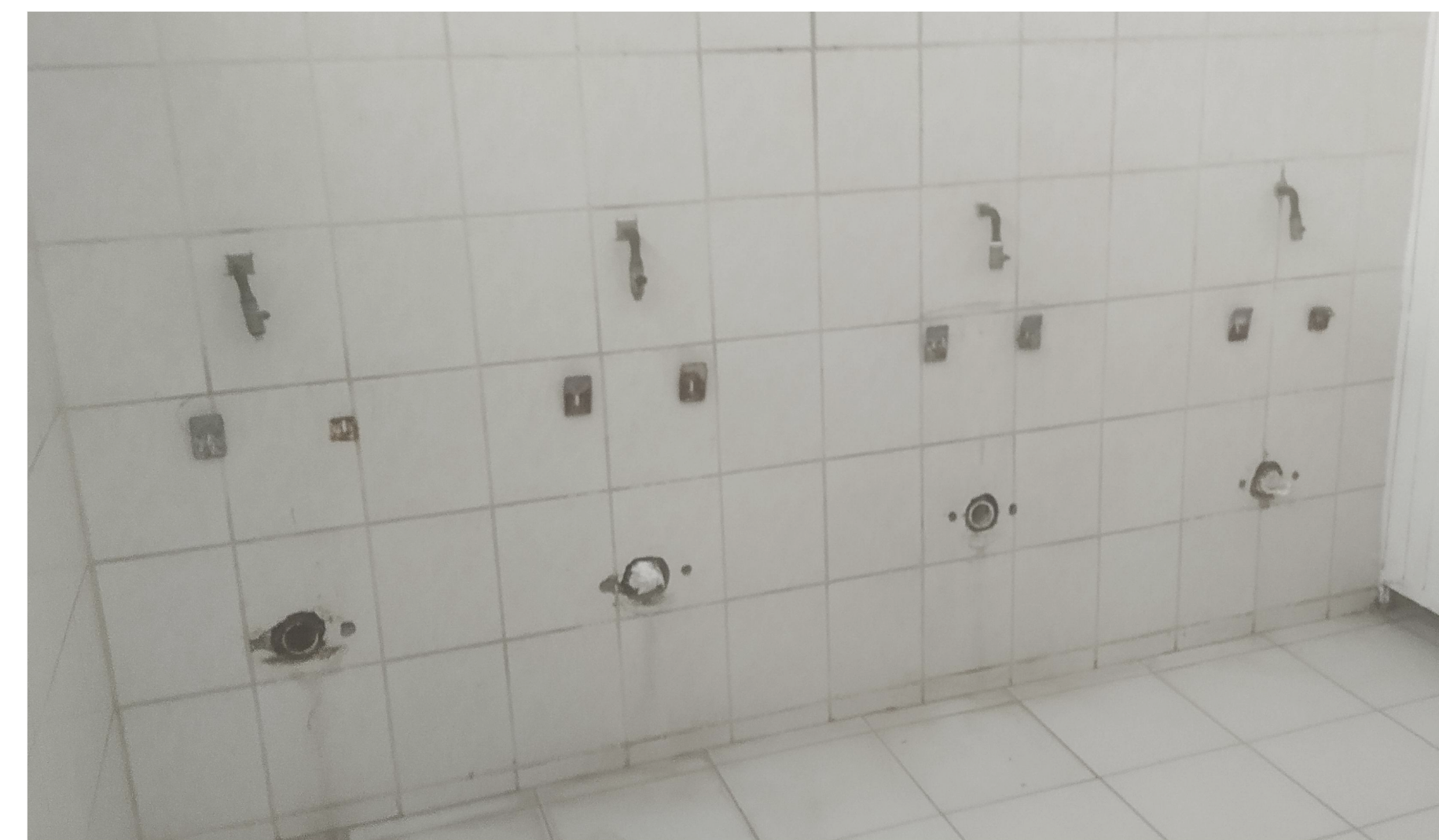
Imagen 06 Estado actual de módulos de sanitarios
