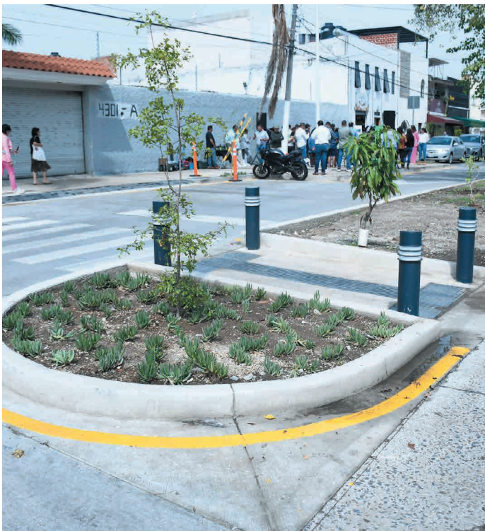
Zapopan trabaja, trabaja y trabaja para mejorar los espacios públicos, haciéndolos inclusivos y funcionales.
