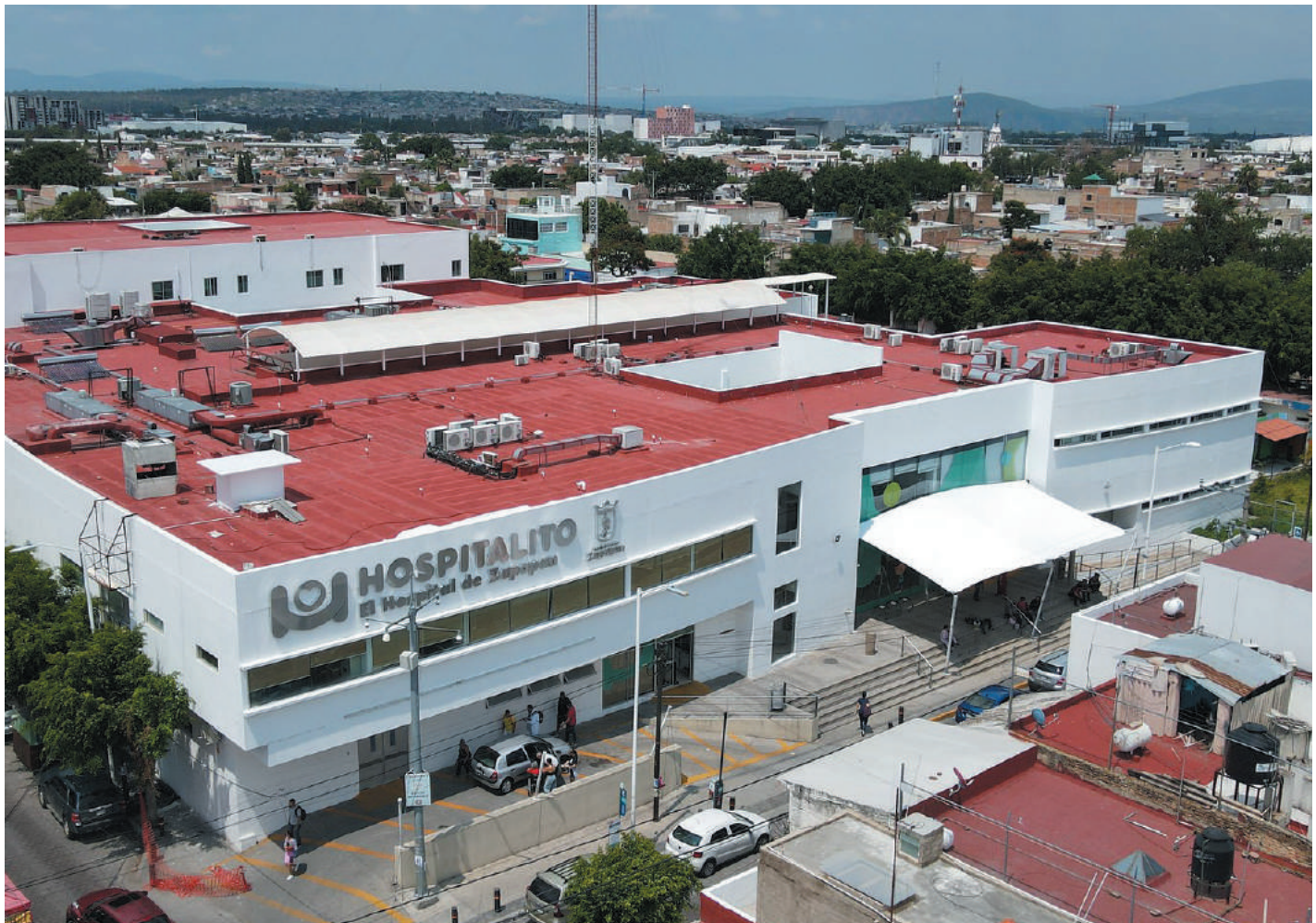
Renovamos las instalaciones del Hospitalito para seguir ofreciendo el mejor servicio a las y los zapopanos.
