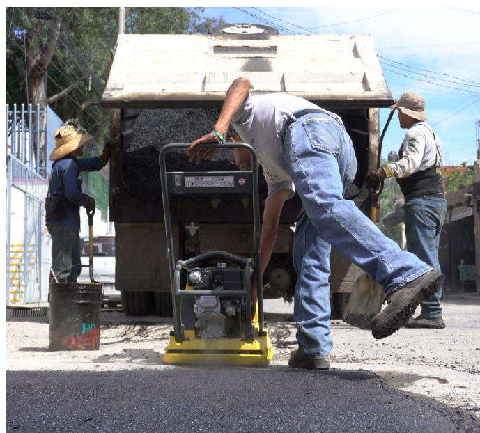
Bacheo, limpieza, arreglo de luminarias, son algunos de los servicios que realizan las cuadrillas en las colonias.
