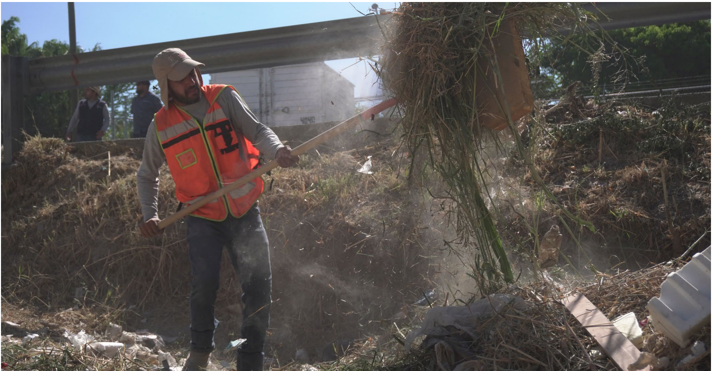
Dimos mantenimiento, con servación y limpieza de redes e infraestructura hidráulica y sanitaria.
