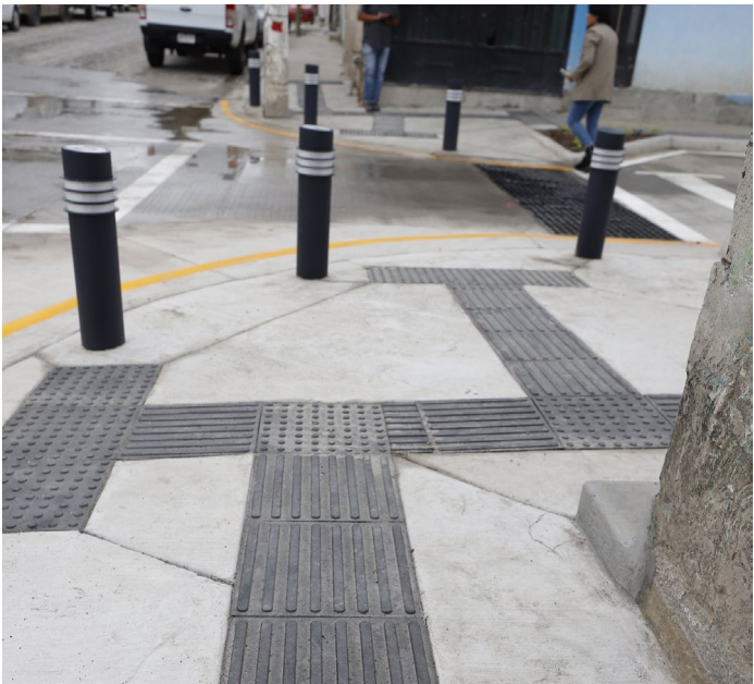
Durante el trienio se han visitado un total de mil 465 colonias para realizar obras de mejoramiento urbano.
