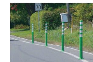
Bolardo flexible para ciclovía, a base de plástico polietileno flexible, color verde, de 1.20 m de altura y con cuatro bandas reflectivas, acoplado en concreto existente con tornillos para concreto de 10 x 64 mm, reforzado con resina epóxica.
