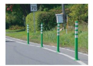
**Bolardo flexible para ciclovia**, a base de plástico polietileno flexible, color verde, de 1.20 m de altura y con cuatro bandas reflectivas, acoplado en concreto existente con tornillos para concreto de 10 x 64 mm, reforzado con resina epóxica.
