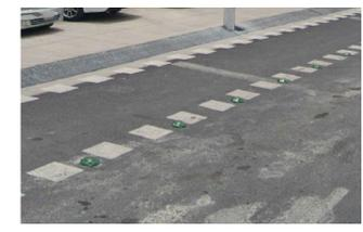
**Vialtón circular cónico con meseta**, a base de poliuretano reforzado, resistente a alto impacto, rayos ultravioletas, ozono, e hidrocarburos y abrasión, color verde con medidas de 20.00 cm de diámetro, altura de 5 cm, con Elementos vinílicos reflejantes de grado alta intensidad en color blanco en al menos 2 caras del elemento.
