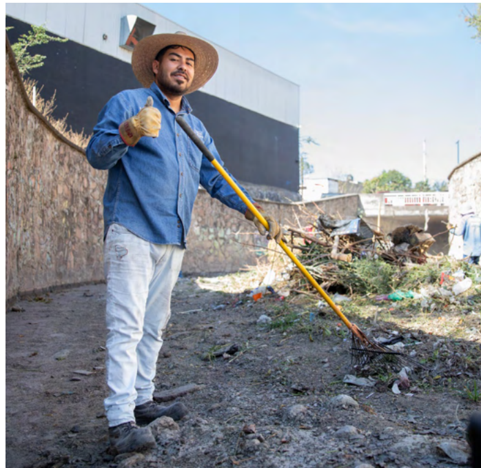
Dimos limpieza y mantenimiento a 35 secciones de canales y arroyos retirando maleza y desechos sólidos como labor preventiva frente al temporal de lluvias.
