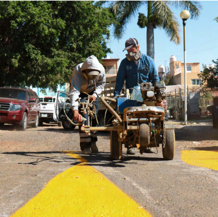
Los trabajos de mejoramiento urbano dieron una nueva cara a calles, avenidas y espacios públicos.
