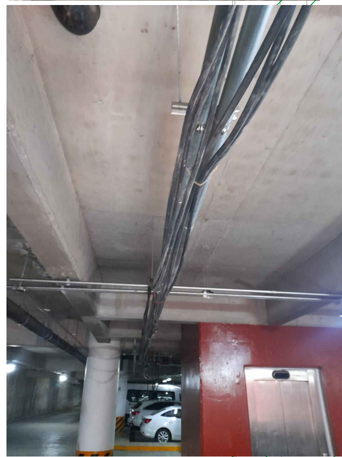
SIN TUBO 2F #4/0 CU 1F #250 CU 1N #4/0 CU
